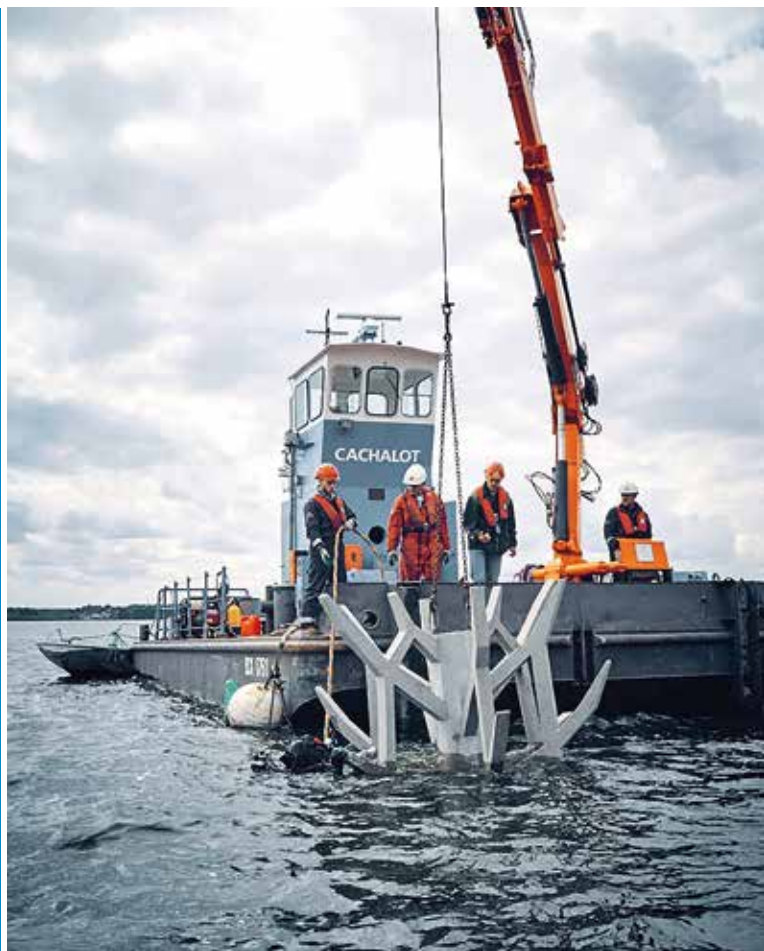
Pose de récifs artificiels dans le lac de Parentis.
