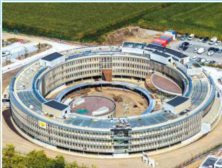
Après ses locaux du Houga [Gers] et de Cugnaux [Haute-Garonne] – premier bâtiment de Midi-Pyrénées certifié Haute qualité environnementale [HQE®] et labellisé Bâtiment basse consommation [BBC] – TIGF a inauguré à Pau en avril 2015 son nouveau siège social, l'Espace Volta, recouvert de 400 m 2 de panneaux photovoltaïques.
