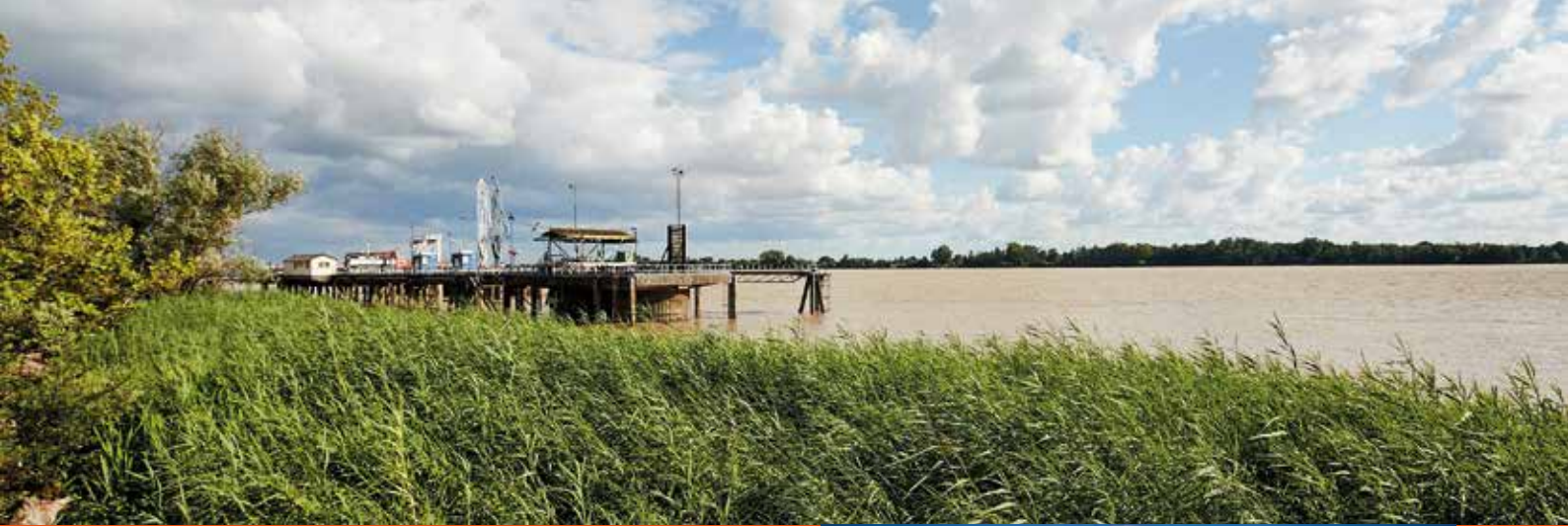
Poste de chargement du port pétrolier d'Ambès (Gironde).
