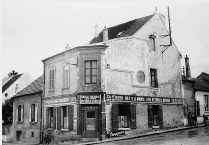
Le « Bar de la mairie et des pétroles réunis » de Nanteuil, commune de Seine-et-Marne accueillant la base opérationnelle de Pétrorep pour l'exploitation du gisement de Coulommes.
