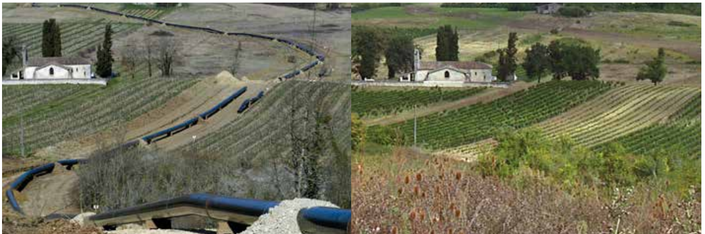
Les « chantiers verts » de TIGF sont entièrement conçus pour répondre à la logique ERC (Éviter – Réduire – Compenser) : définition des tracés de canalisation en évitant les zones naturelles sensibles ; réduction à minima du déboisement ; remise en état selon les techniques de génie écologique les plus appropriées...
