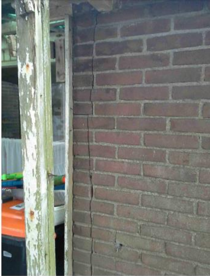
Garage/schuur, Voorgevel: Scheur, (ernstig > 5 mm, verticaal)
