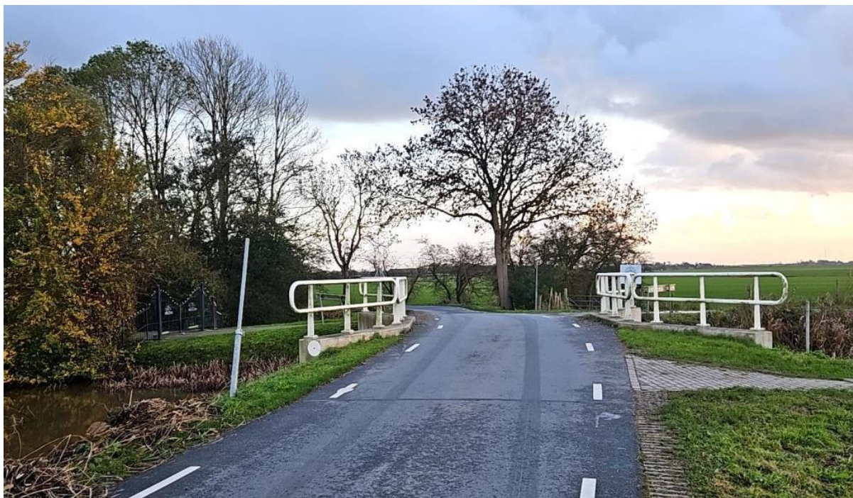
Figuur 2-5: Foto van peilmerk aan een brug.
