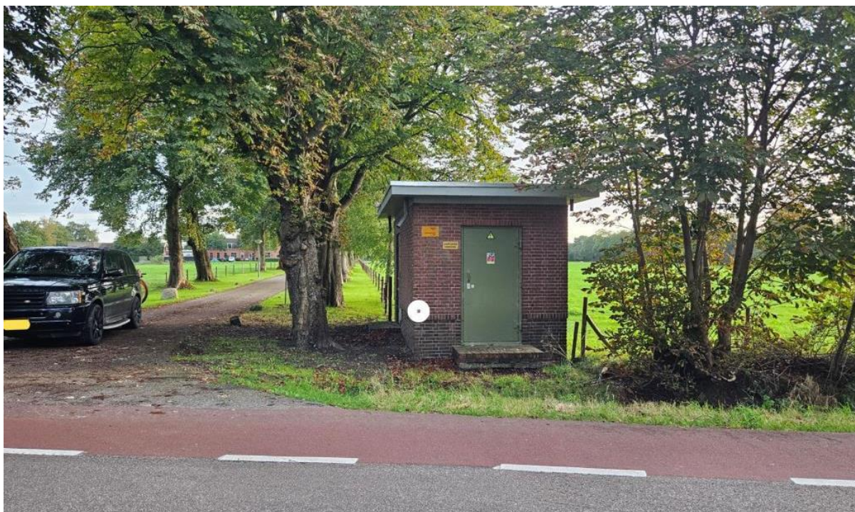
Figuur 2-6: Foto van peilmerk aan een elektriciteitsgebouwtje.
