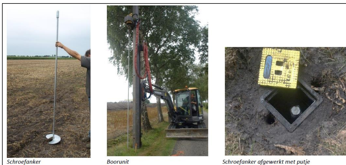
Figuur 2-7: Foto voorbeelden van een schroefanker.
