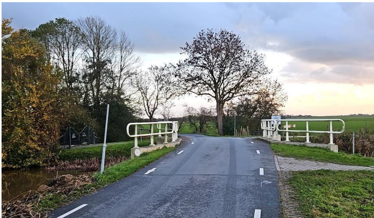
Figuur 2-5: Foto van peilmerk aan een brug.
